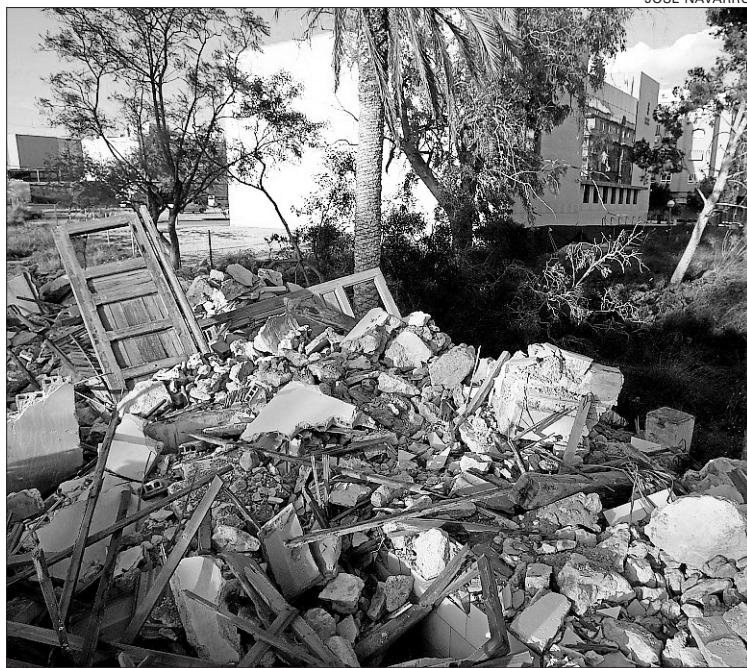
Imagen de los escombros, con el edificio de los Juzgados al fondo
